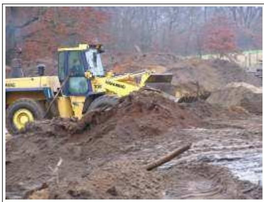
Inwestycje w toku: budowa boiska w Dobrowie
